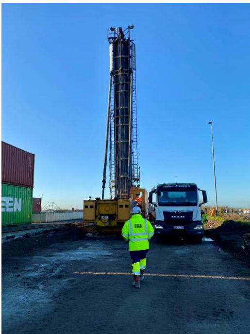
Sehr beengte Platzverhältnisse mit Breiten der Arbeitsebene bis 7,50m konnten bei der Pfahlherstellung erfolgreich berücksichtigt werden. © PORR
