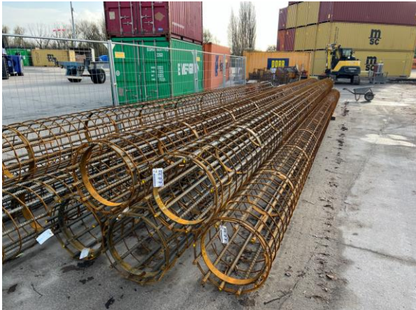
Bewehrungskörbe für die Pfahlherstellung. © PORR
